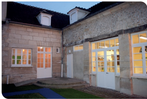
Les locaux de l'ancienne halte-garderie de Saint Péravi pourraient bientôt accueillir les services de l'Inspection de l'Éducation nationale
